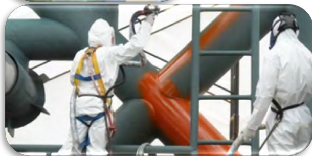
柱脚・構造物の強化・防錆
