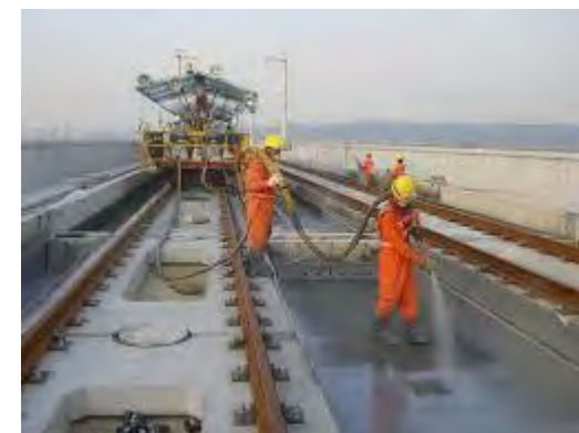
プラットフォーム防水(将来、短時間でのメンテが難しい)
