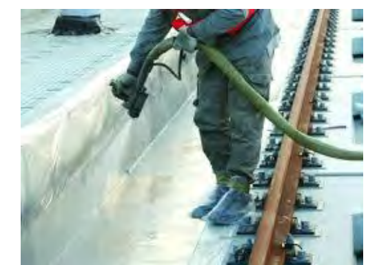
プラットフォーム防水(将来、短時間でのメンテが難しい)
